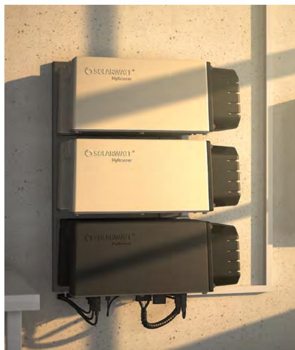
MyReserve ist modular aufgebaut, aus einer schwarzen Steuereinheit (Command) und Batteriemodulen (Packs).
